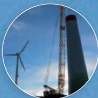
Im Januar 2013 ist der Turm bereits 80 Meter hoch und die Baustelle wird für die nächste Bauphase vorbereitet. Der bisherige Kran muss einem größeren Modell weichen, das die Gondel mit Maschinenhaus, Generator, Rotornabe und -blättern auf eine Höhe von 135 Metern hieven kann.
