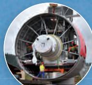
Im Oktober 2013 wurde zunächst die Gondel mit Maschinenhaus aus mehreren Teilen zusammengesetzt und anschließend die jeweils 50,5 Meter langen Flügel, auf 135 Meter Höhe, am Maschinenhaus montiert. Danach waren die Verkabelungsarbeiten in vollem Gange – bald soll Baden-Württembergs größte Repowering-Windkraftanlage ans Netz gehen und Strom erzeugen.
